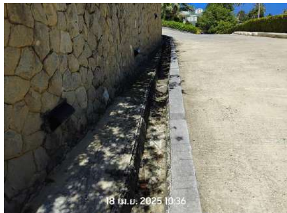
รูปที่ 2.2 ท่อระบายน้ำฝน
